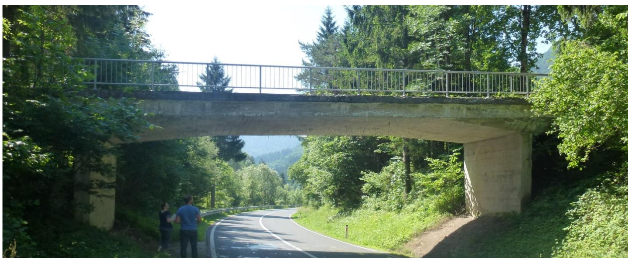
Slika 6: Pogled na objekt
