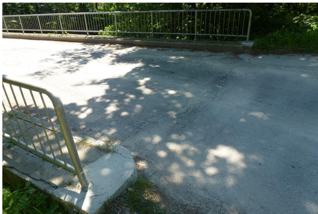
Slika 11: Prehod na območju hodnika je stopničast, ker se je stožec posedel
