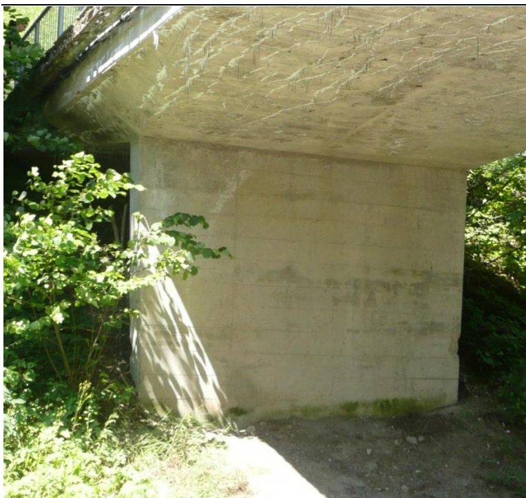
Slika 14: Stebri so v napram ostali konstrukciji v dokaj dobrem stanju, vendar se tudi tu pojavljajo lokalne poškodbe, predvsem na vogalih stebrov, v obliki odstopanja betona na mestih s premalim zaščitnim slojem betona
