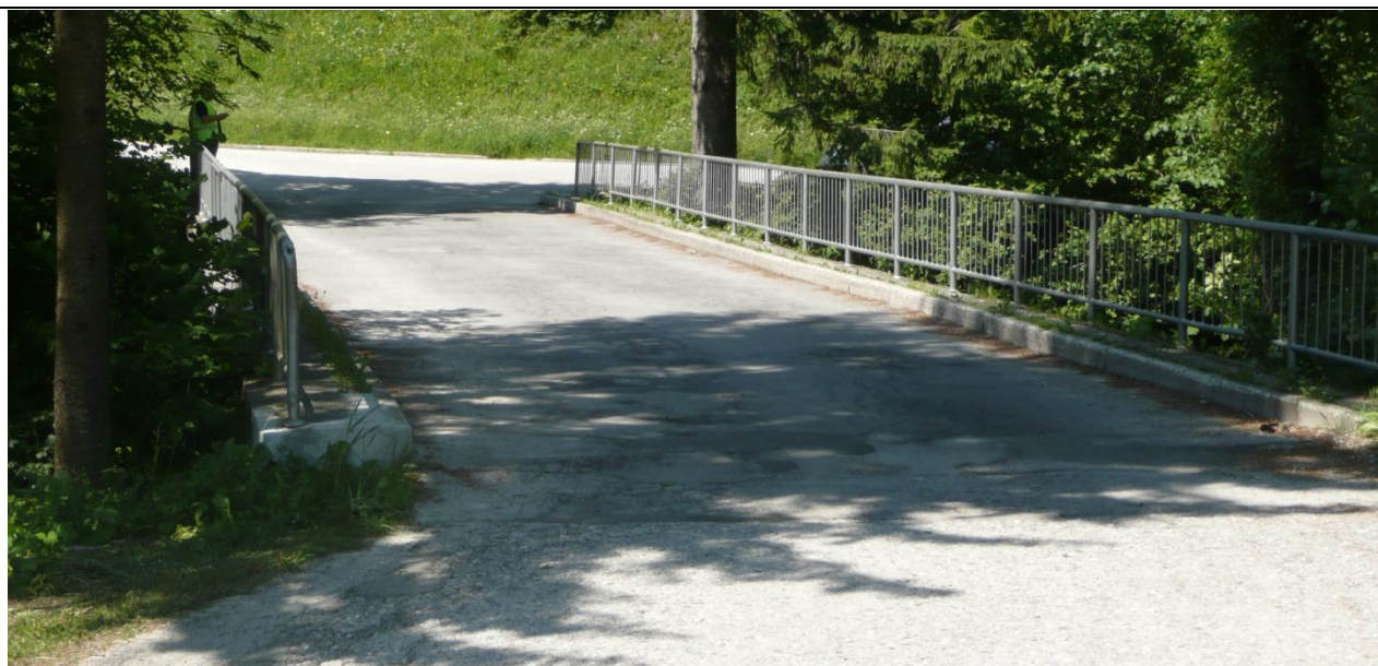
Slika 5: Pogled na zgornjo konstrukcijo
