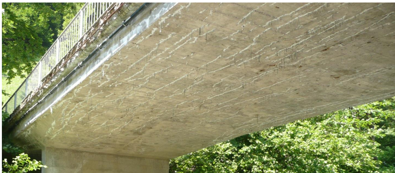
Slika 12: Na spodnji površini so vidne zasigane razpoke
